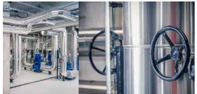
BROEN Ballomax®-Kugelhähne steuern den Durchfluss von Fernwärmewasser.
